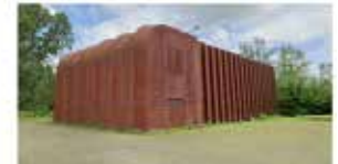
150 kV-station Opdrachtgever: Liander Beleidsadviseur: Dijksterhuis Stuvia Projectarchitect: Liander Architect: A. Dijksterhuis Beleidsadviseur: Dijksterhuis 2017-2018
