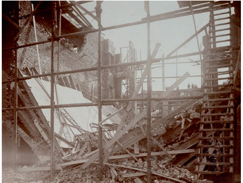
Da Costakade 1902. In de 19 e en begin 20 ste eeuw werd slecht gebouwd. Soms stortten panden al in tijdens de bouw. Bron: Stadsarchief Amsterdam
