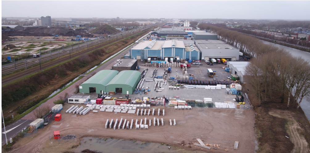
Figuur 1: De BouwHub van VolkerWessels Bouwmaterieel, bron VolkerWessels Bouwmaterieel
