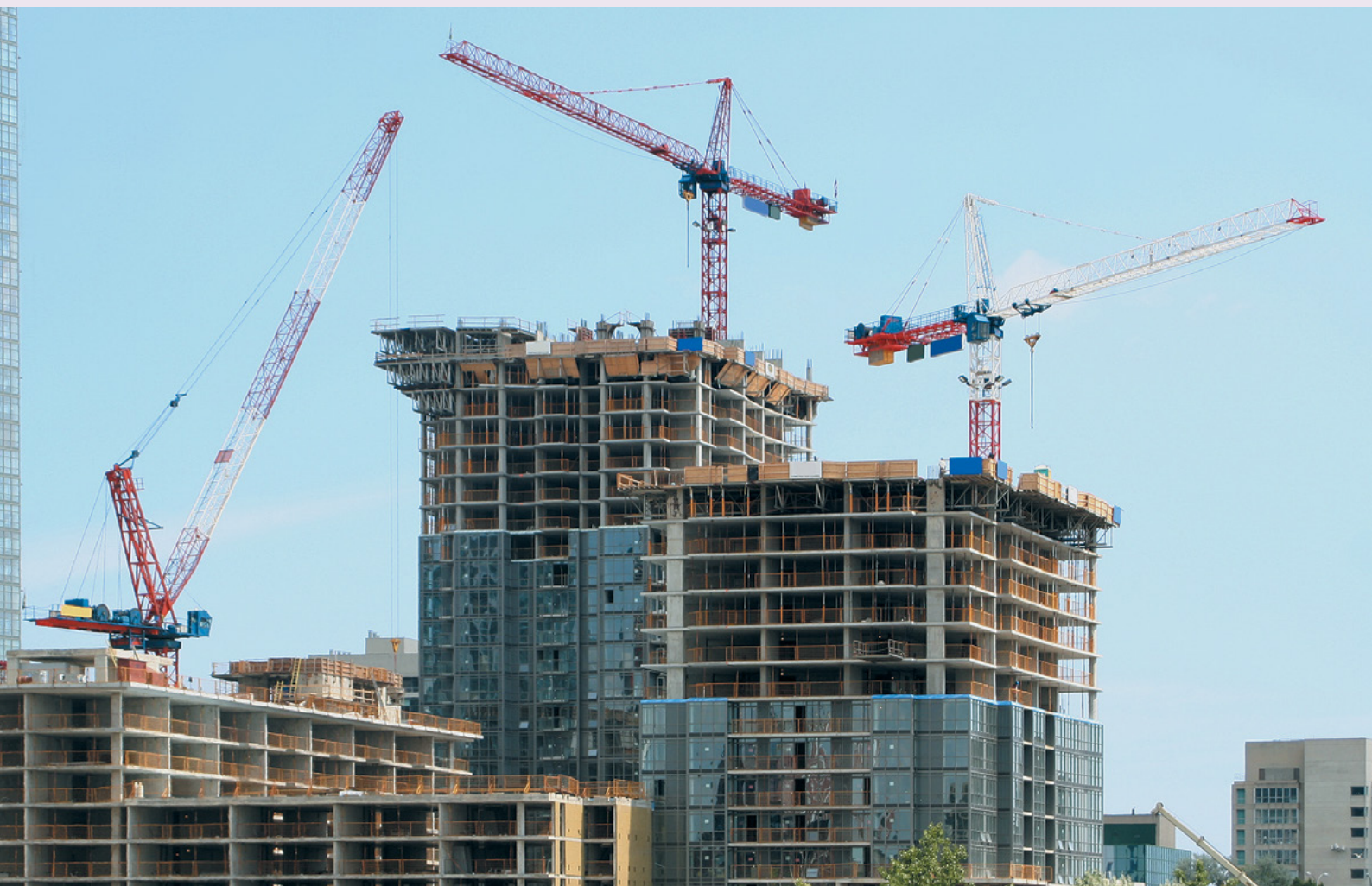
FIGUUR 4.6: KANTOORGEBOUW IN AANBOUW
